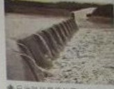
日治時代興建的萬里大壩，為臺灣最大的水利工程。
