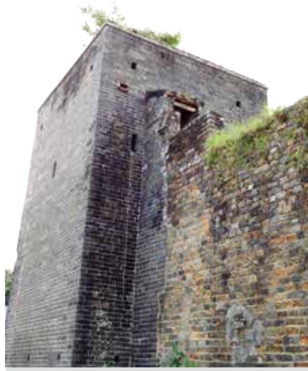
吉慶圍的四角築有砲樓，牆上鑿有槍孔。
